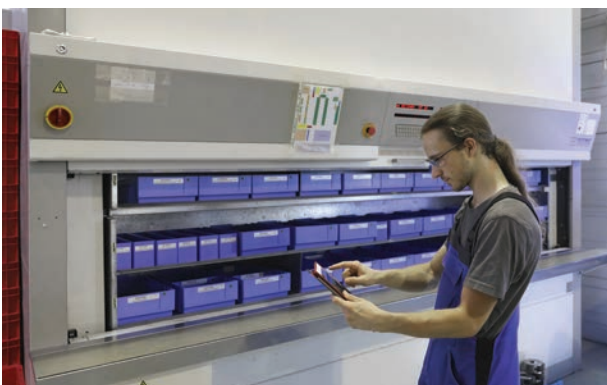
Abbildung 4: Vorbereitung der Montage eines Antriebs bei der PS Automation GmbH
