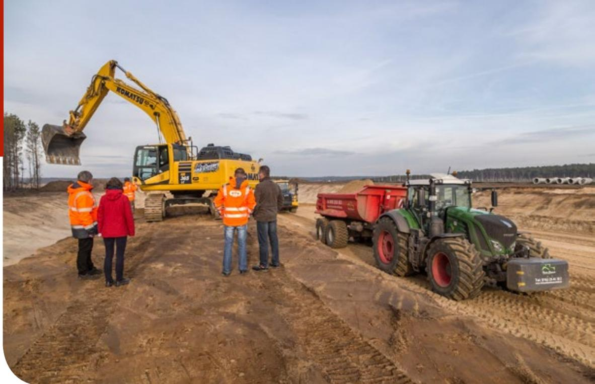
Mit Hilfe der Daten und Informationen aus dem 3D-Modell können Raupen fein und Grader sehr fein gesteuert werden: Das Schild wird dank der präzisen Daten in die exakt richtige Neigung eingestellt. Bagger werden zwar noch nicht vollautomatisiert gesteuert,
